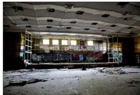
Für den Veranstaltungssaal der Parteischule gibt es keine wirtschaftliche Zukunft, er soll samt Mensa abgerissen werden.
