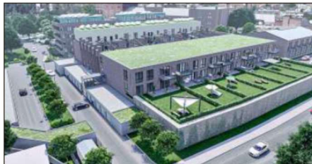
Direkt neben dem Neubau aus Holz (im Hintergrund) ist die Sanierung des ehemaligen Großlagers (vorne) vorgesehen.
