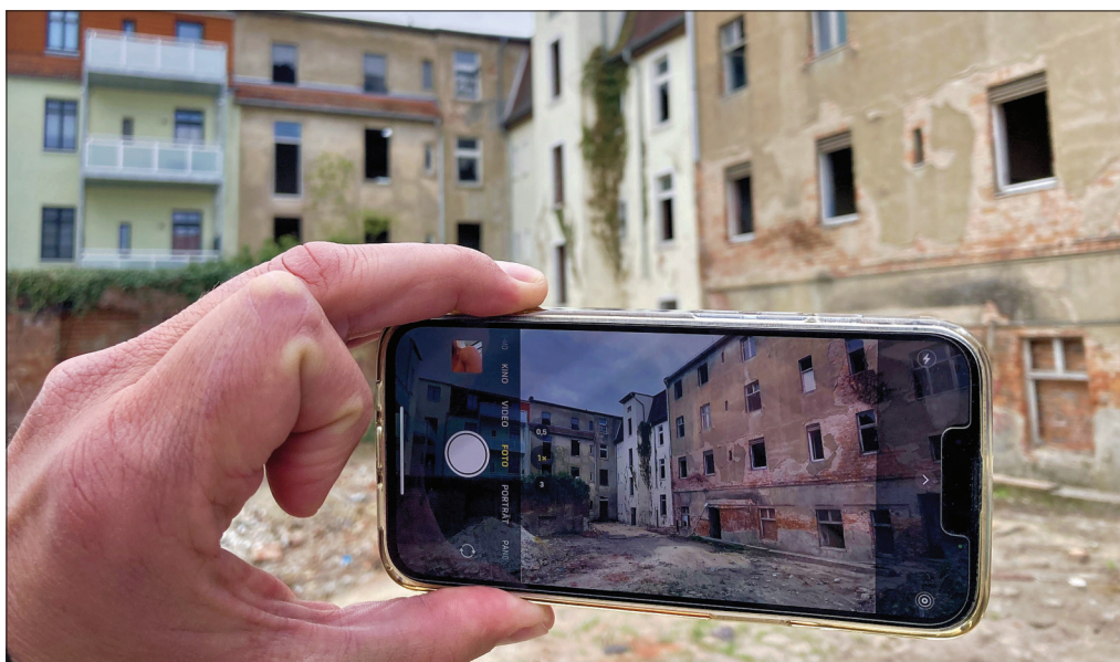
Vom Hinterhof aus lässt sich erahnen, welch großer Aufwand nötig ist, um den Ende des 19. Jahrhunderts errichteten Häuserzug im Engpass der Hauptverkehrsachse Alt-Salbke zu retten. Ende 2024 soll das erste Haus fertiggestellt sein.
